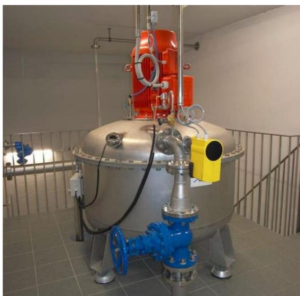
Figure 21 : Turbine Pelton à contre-pression sur le captage des Stilles. Source : Ribl SA
